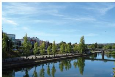
Le pont de l'Europe et l'échangeur estompé par la végétation
