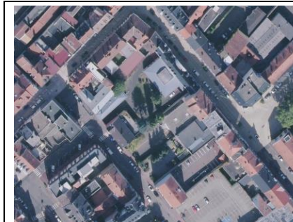
Photo aérienne de la partie Nord-Ouest de l'îlot
