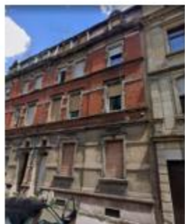
27 rue du Lycée
