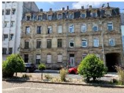
12 chaussée de Louvain (3 log – LHI)
