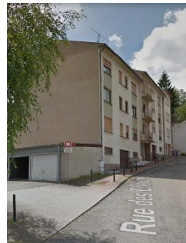
Résidence Plein Centre, rue des Chèvres
