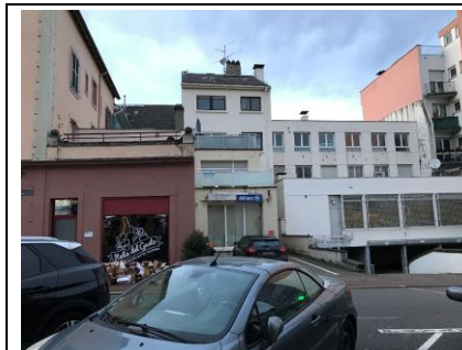
Front bâti discontinu formé par les extensions, rue des Vosges
