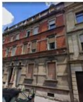
27 rue du Lycée (1 log – LHI)
